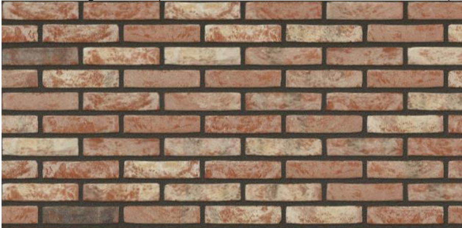
Afbeelding 1: metselwerk type A
